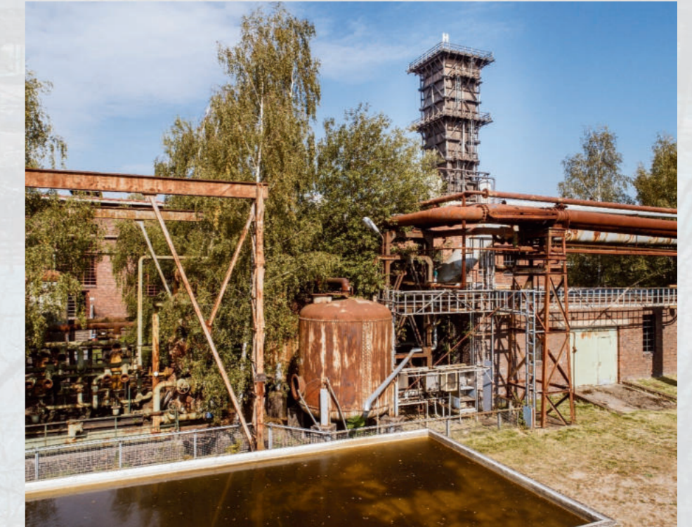
Wasserbecken, Rohrleitungen, Förderanlagen, rostiges Eisen durchdrungen von Natur. Artenreichtum auf engstem Raum (Kokerei Hansa).
