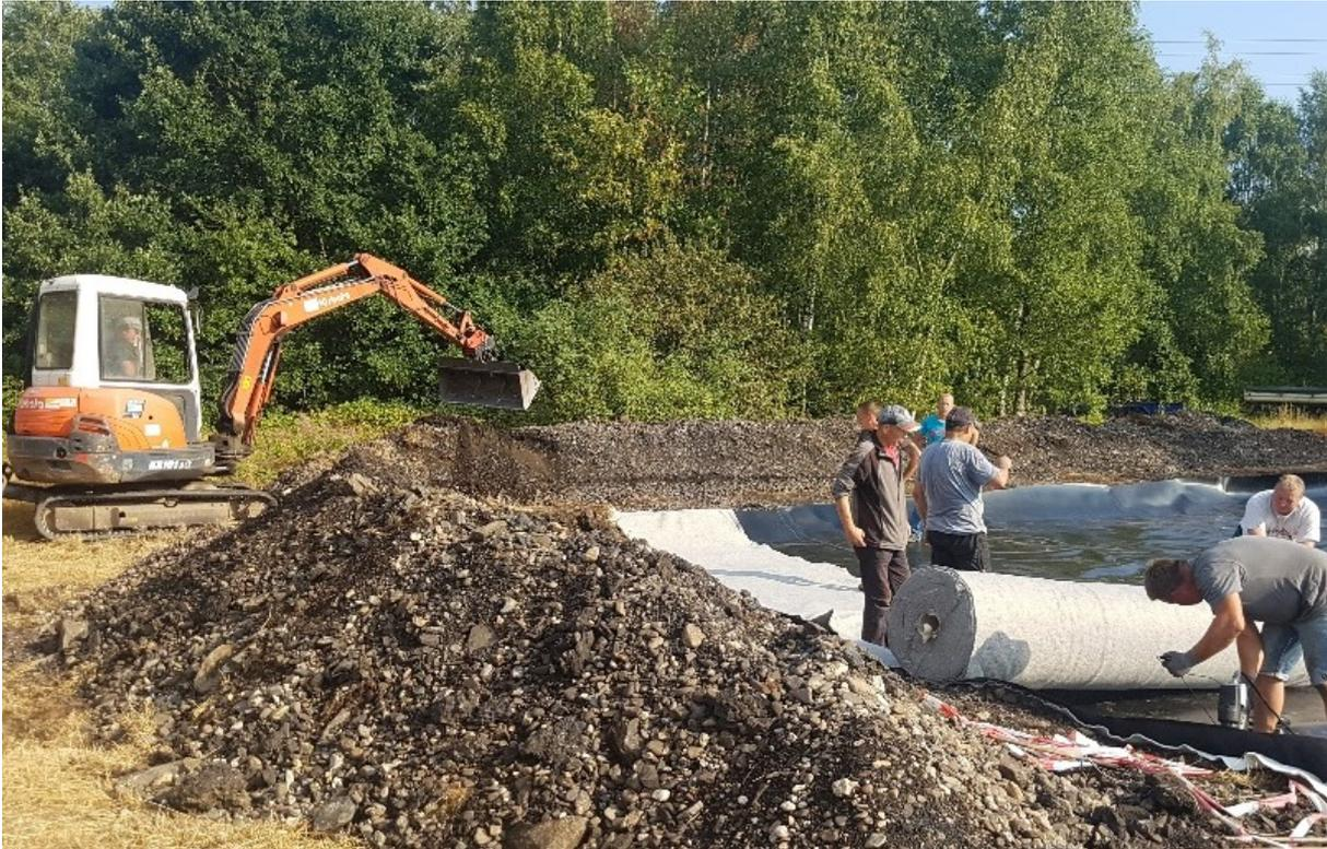
Abb. 7: Anlage eines Artenschutzgewässers im Gleispark Frintrop zur Initiierung einer Kreuzkrötenpopulation. Nach Einbau der Folie wird diese mit dem anstehenden technologenen Substrat wieder überdeckt.
