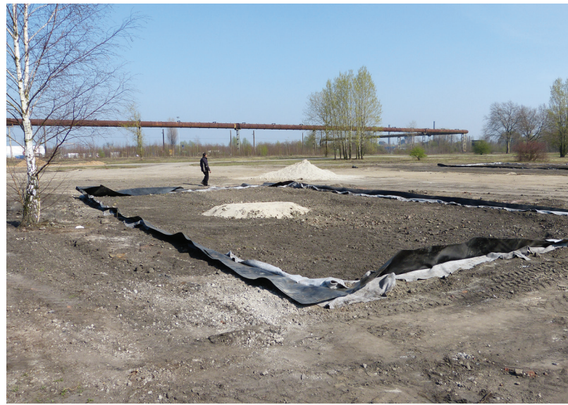
Abbildung 173: Bau der Ersatzgewässer 2012 im Landschaftspark Duisburg Nord
