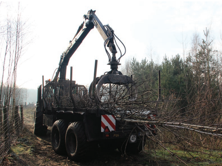
Abbildung 43: Rodungsarbeiten am Ostufer des Haubachsees
