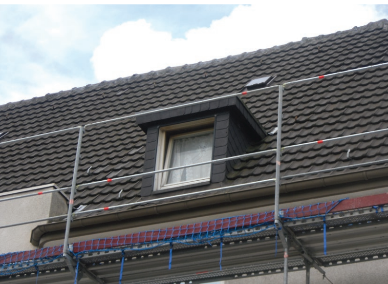
Abbildung 121: Heruntergelassene Netze am Gerüst vor den Mauersegler-Nistplätzen im Sommer 2016
