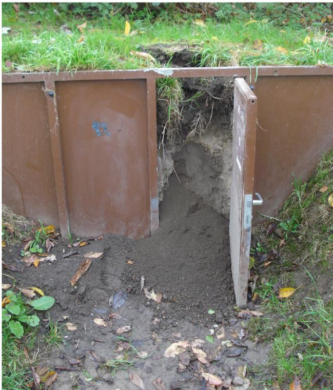
Abbildung 169: Schäden an einer Station des Mülheimer Bodenlehrpfades
