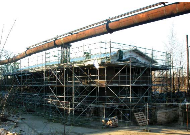
Das denkmalgeschützte Gebäude der Dependence im Landschaftspark Duisburg-Nord am 10.01.2005 während der Sanierungsphase (Foto: BSWR)
