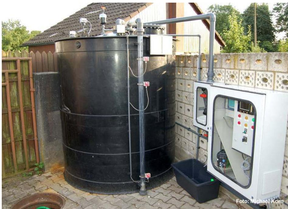
Abb. 5: Dosieranlage für Eisen III-Chlorid
