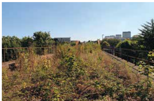
► Ruderalvegetation auf der Ruhrbrücke vor dem Bau des RS1
