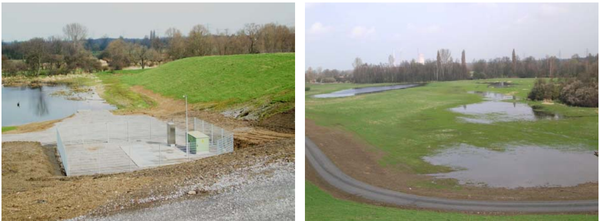
Abb. 5-6: Errichtung eines Pumpwerkes und Anlage eines Deichverteidigungsweges im südlichen Deichabschnitt.
