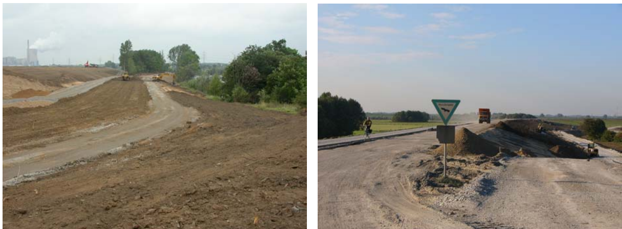
Abb. 7-8: Rodung von Gehölzen und Anlage eines Deichverteidigungsweges beiderseits des Deiches.
