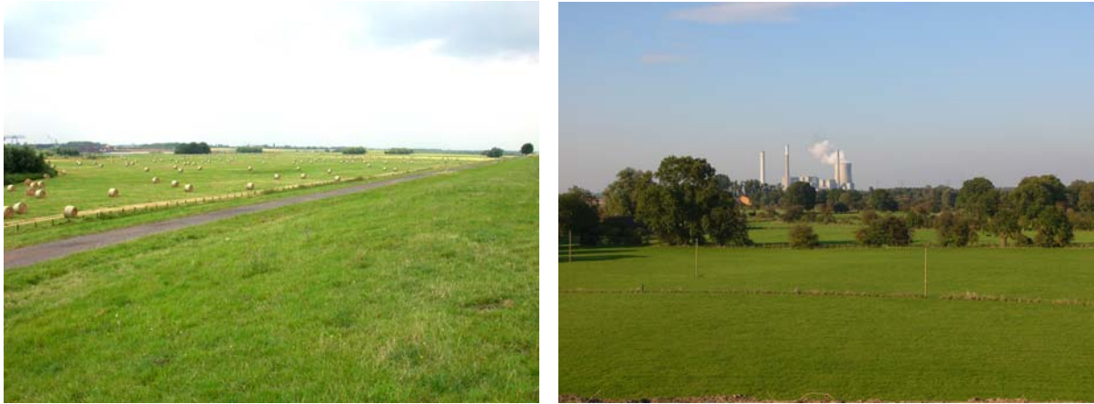
Abb. 1-2: Blick vom Deich in das Vorland (l.) und in das Binnenland in Richtung Kraftwerk Voerde (r.).
