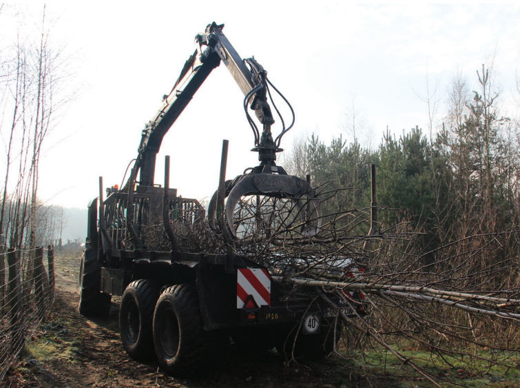
Abbildung 43: Rodungsarbeiten am Ostufer des Haubachsees
