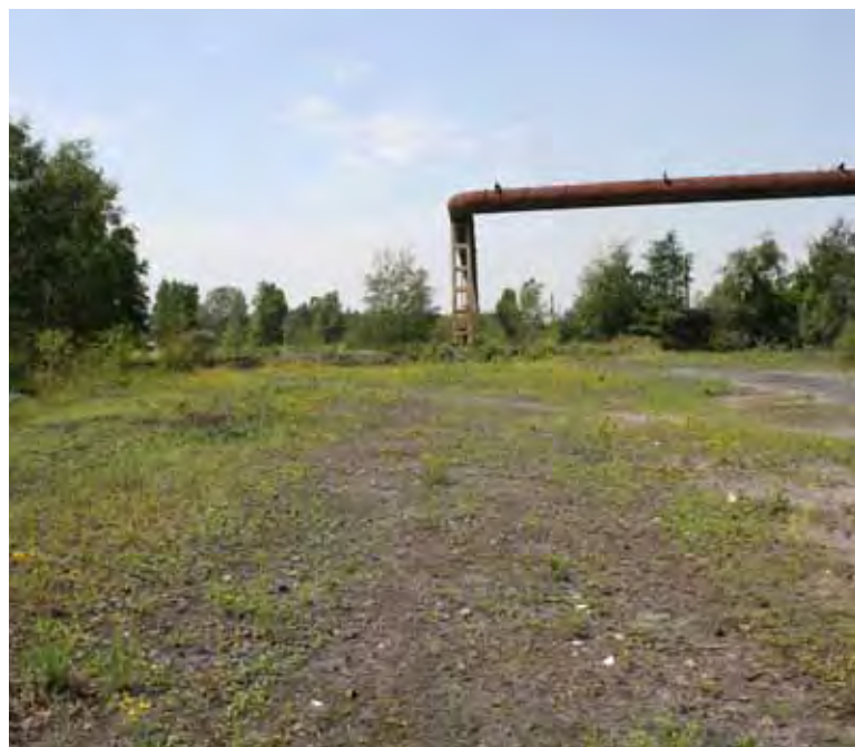
Abbildung 83: Monitoringfläche auf dem Schachtgelände des Landschaftsparkes.
