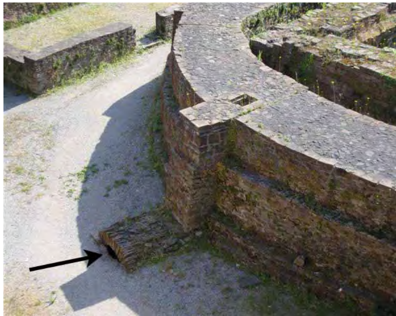
Abbildung 46: Unterirdischer „Kellerraum“ (Pfeil) im Innenhof von Schloss Broich mit Luftschacht.
