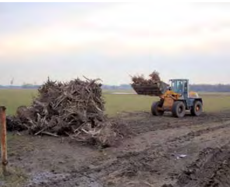
Abbildung 12: Rodungsarbeiten im Vorfeld der Anlage eines Gewässers im Deichvorland Der Walsumer Rheinaue.
