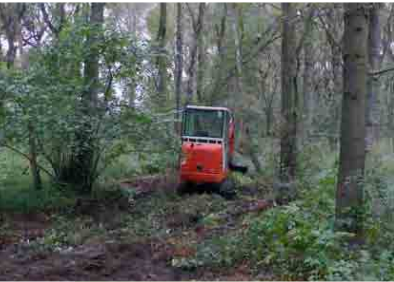
Abbildung 18: Im Bissingheimer Wäldchen wurden die Abzugsgräben mit einem kleinen Bagger und per Hand wieder geschlossen.
