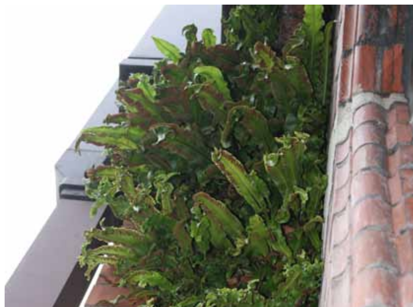
Abbildung 77: Hirschzungen an einer Hausfassade.
