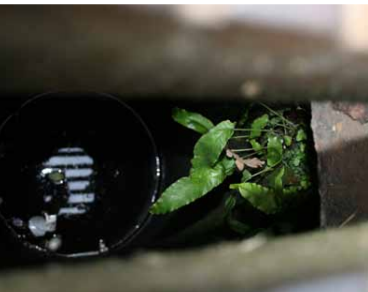
Abbildung 75: Hirschzungen in einem Gully.
