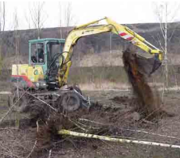
Abbildung 67: Zu Erhaltung der Offenlandflächen werden im Landschaftspark Duisburg Nord auch Bagger und Planierraupen eingesetzt.
