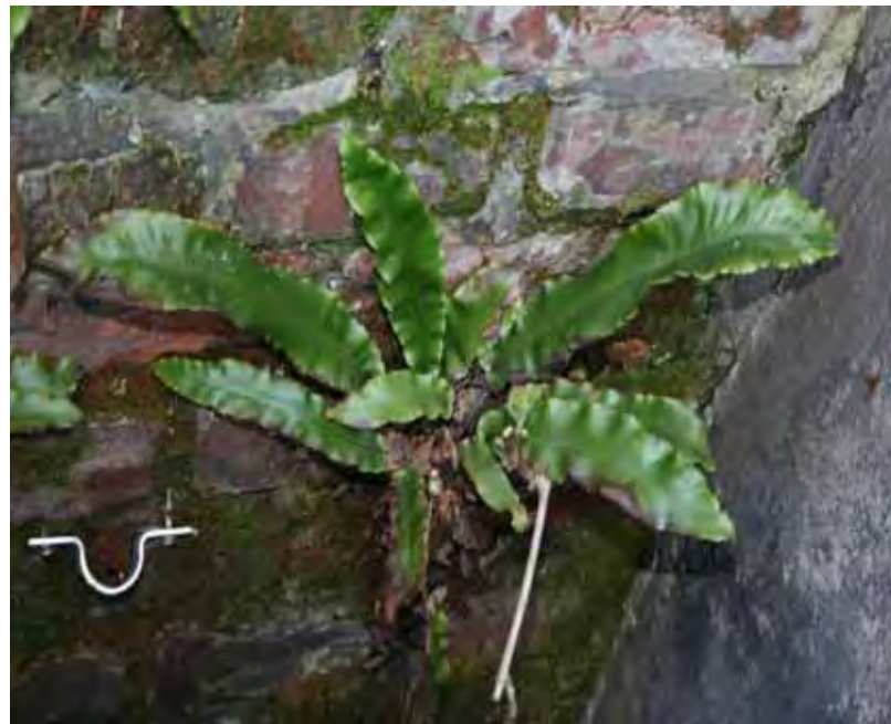
Abbildung 76: Hirschzungen in einem Kellerlichtschacht im Landschaftspark Duisburg-Nord.
