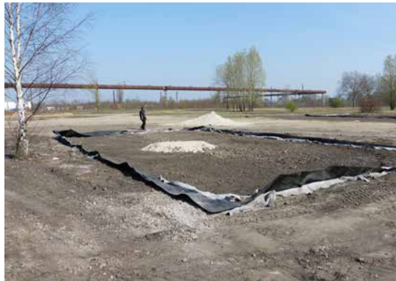
Abbildung 173: Bau der Ersatzgewässer 2012 im Landschaftspark Duisburg Nord
