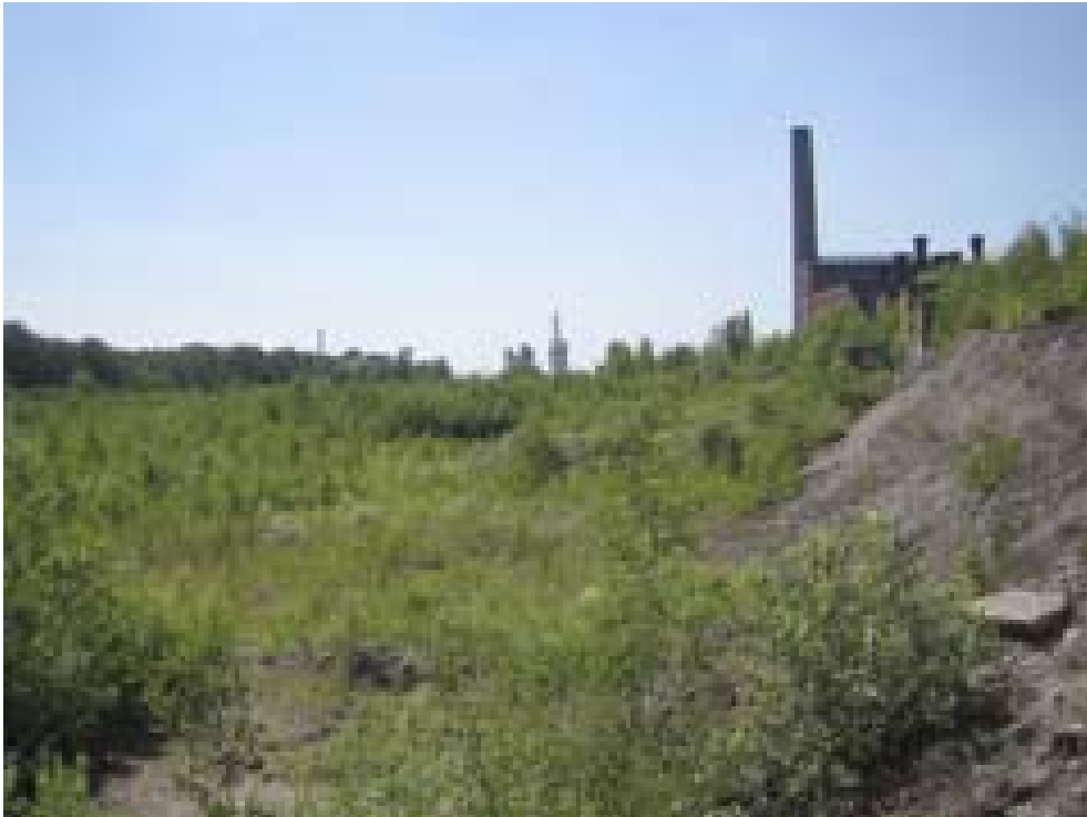
Abb. 1: Ehemalige Sinteranlage in Duisburg
